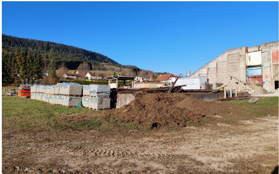
Abb. 7: Westlicher Bereich des Plangebiets mit Ru-derallflächen, Nadelbaumreihe im Hintergrund, gelagerten Baumaterialien und Betriebsgebäuden (Blick nach Südwesten, 23.04.2021)
